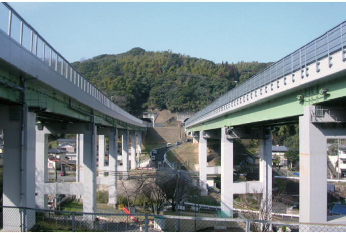
塗替え塗装完了後の金山橋。
