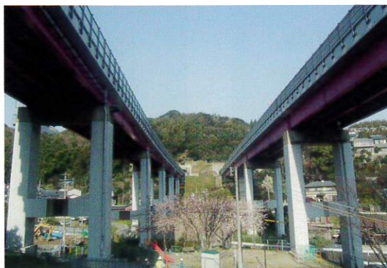
北九州高速4号線 金山橋
