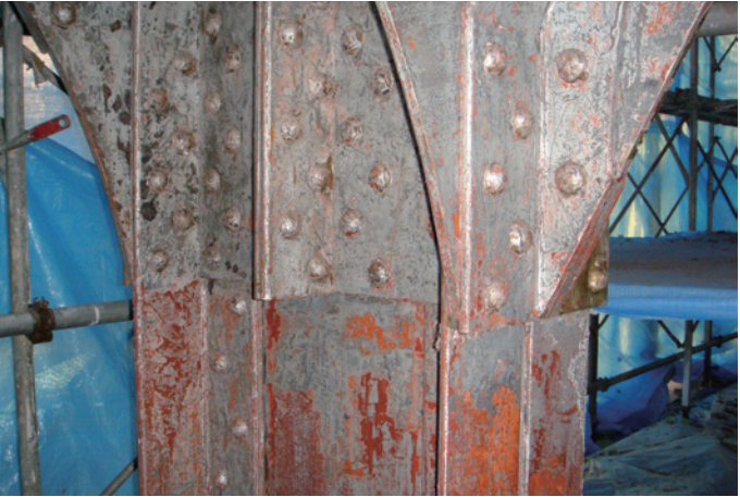
2回目の塗膜の除去作業完了。
