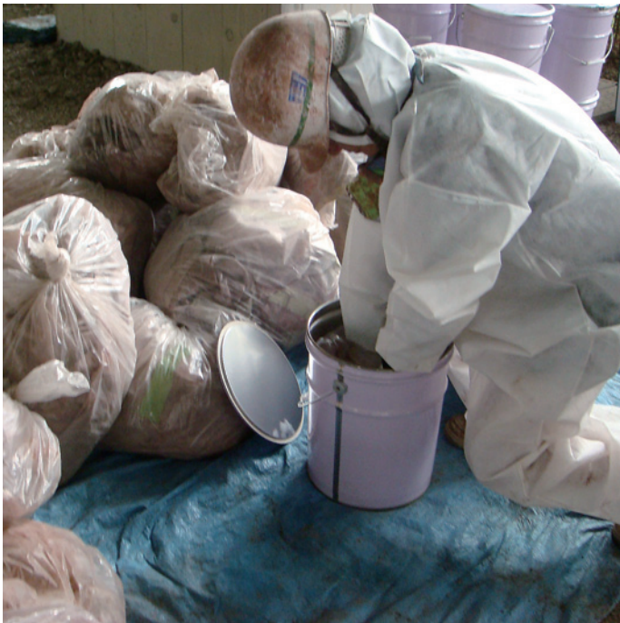
旧塗膜を飛散させずに容易に回収できました。
