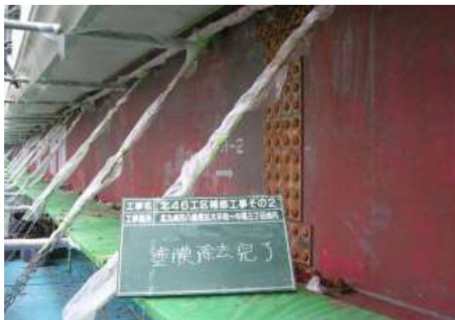
塗膜はく離後
