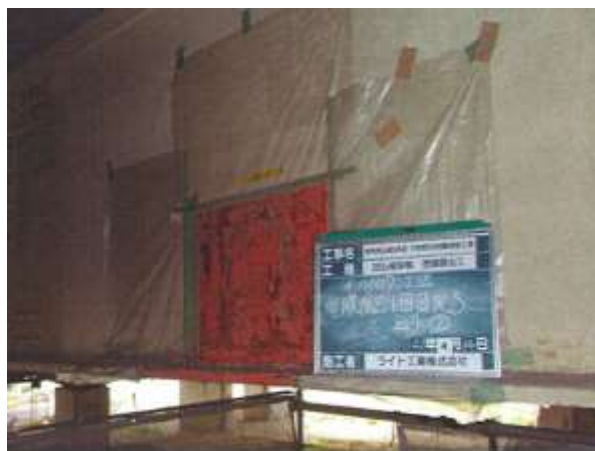
塗膜はく離後
