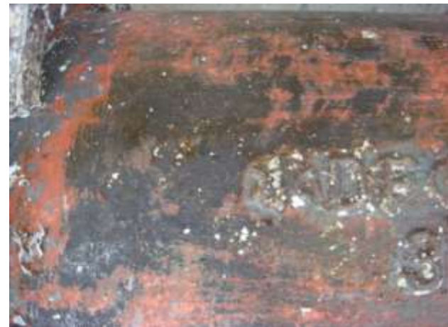
塗膜はく離後
