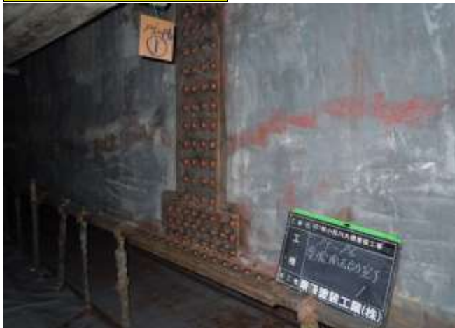
塗膜はく離後
