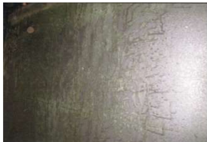
塗膜はく離後
