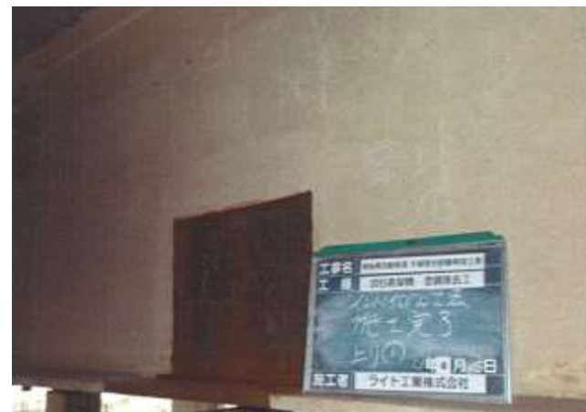
塗膜はく離後
