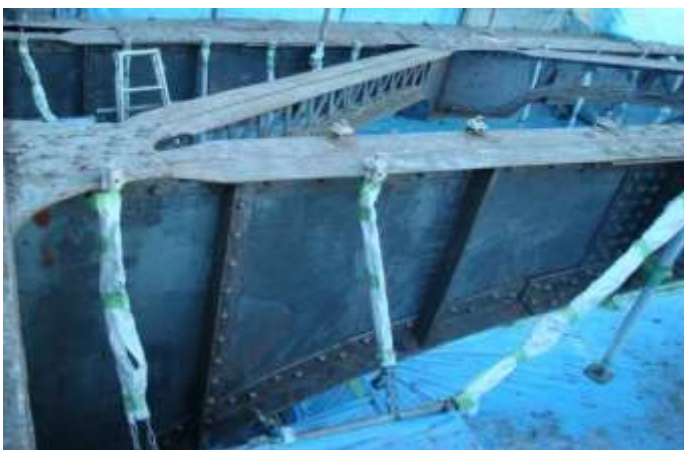
塗膜はく離後
