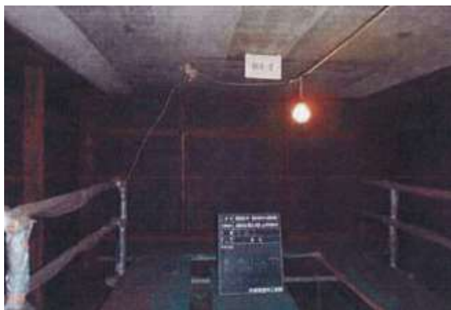
塗膜はく離後
