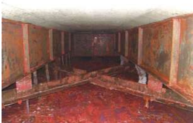
塗膜はく離後
