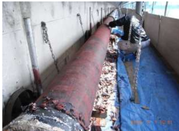
塗膜はく離後
