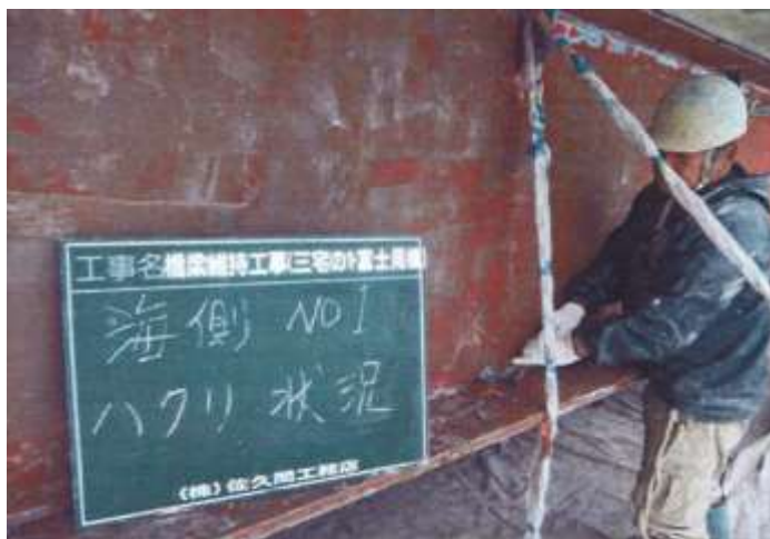
塗膜はく離後
