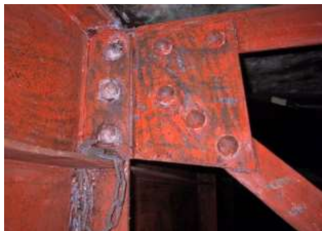
塗膜はく離後
