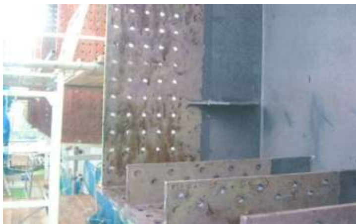
塗膜はく離後
