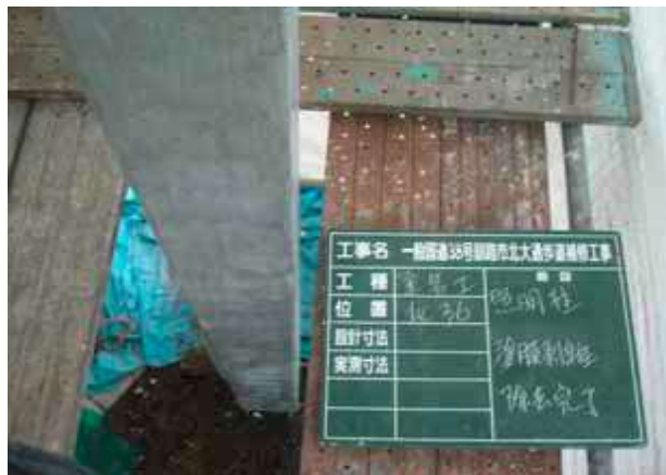
塗膜はく離後
